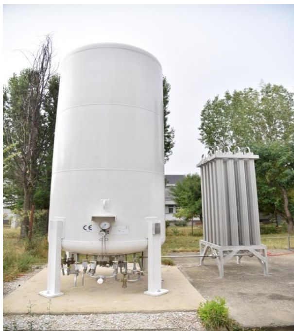
Cryo-tanku 10 Ton, Kl.e Pulmologjisë
