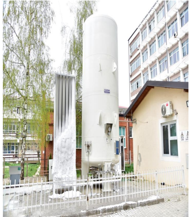
Cryo-tanku 20 T, prapa Kl.Infektive -QKUK
